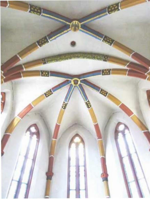
Als weiterer Folgeschaden am Tragwerk wurde erst im Juni 2019 festgestellt, dass die Innenputzdecke des Chores herunterzustürzen droht, weshalb der Chorraum bis zur Anbringung eines Sicherungsnetzes unter der Chordecke vorübergehend gesperrt werden musste. Zur Behebung des Schadens ist die Decke im Chor abzutragen und zu erneuern. Die Kosten, die für diese zusätzliche Maßnahme auf die Kirchengemeinde zukommen, sind noch nicht absehbar.
